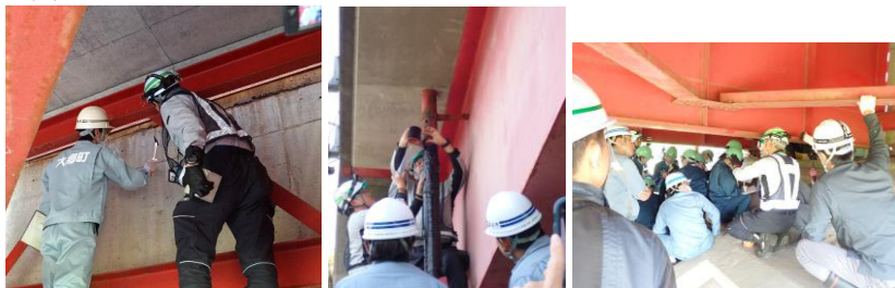
打音検査（左）「ゴリラテープ エクストリームウォータープルーフ」によるテープング（中）防錆剤「ローバルエコタイプ」の塗布（右）
